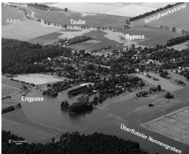
Das südwestliche Aken mit Umflutung (Bypass) des Wehres am Schöpfwerkgraben und des Engpasses (Unterführung) der B 187a am Nonnengraben [Foto-Fritsche, Köthen]
