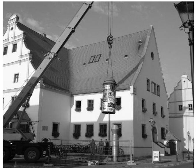
Bei der Überprüfung wurden im Bereich der Fundamentverschraubungen einseitige Durchrostungen festgestellt. Ein Kran musste geordert werden, der die Litfaß-Säule abhob und durch die Luft schweben ließ. Wann sie nach erfolgter Wiederaufarbeitung ihren angestammten Platz einnehmen kann lag zum Redaktionsschluss noch nicht vor.
